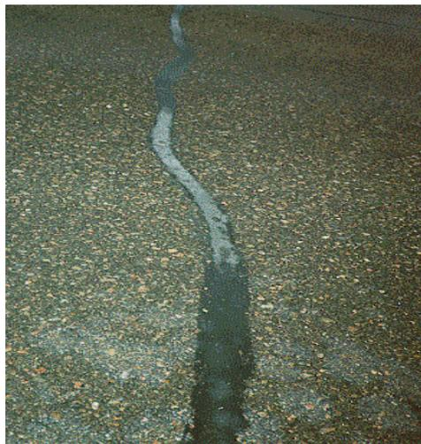
Figure 1 : bon état d'une fissure transversale 2 ans après la pose par colmatage d'un produit performant (autoroute 55 Nord à Trois-Rivières)
