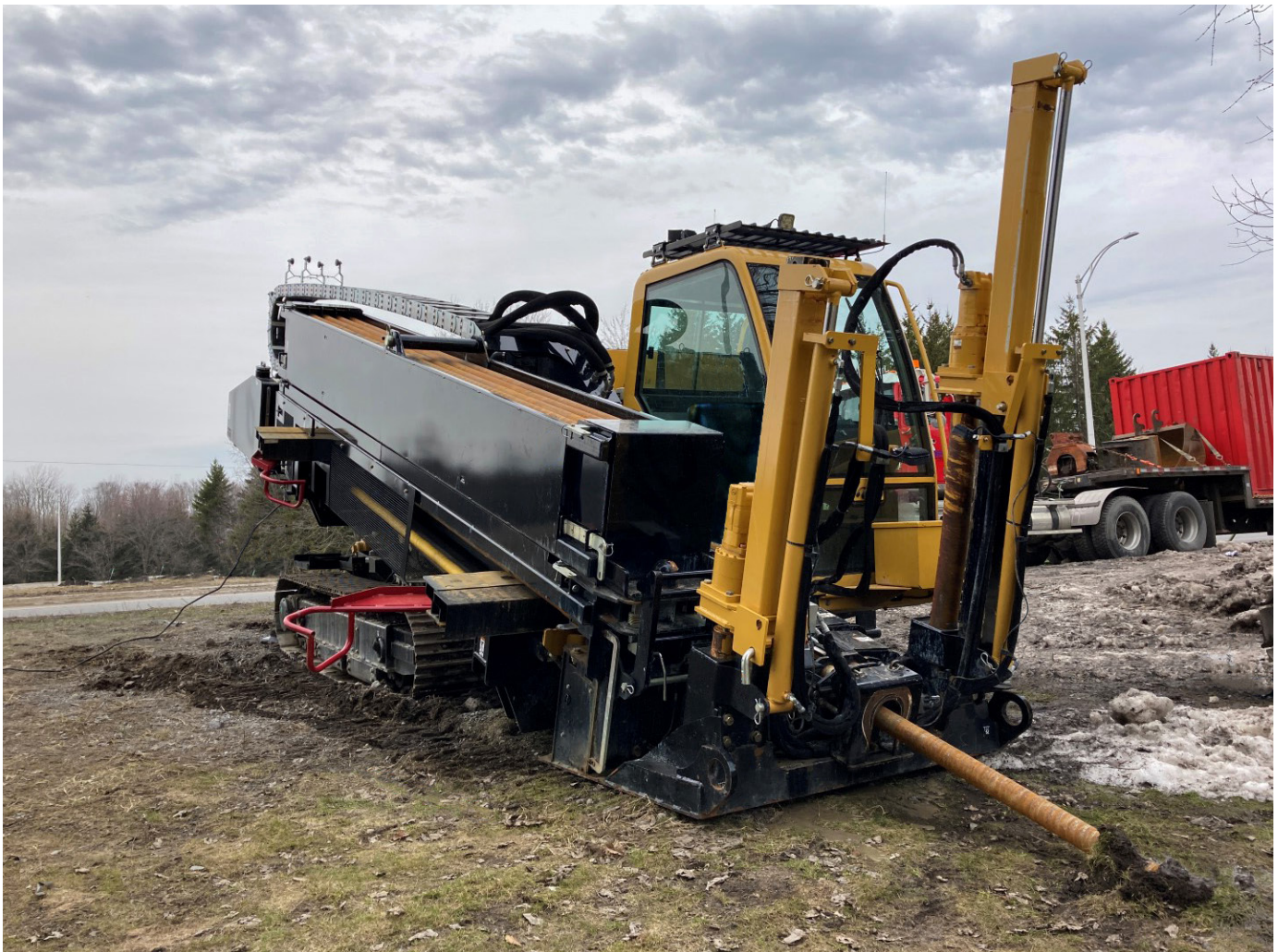
Figure 2 – Installation d'une conduite en forage dirigé (photo 2)
