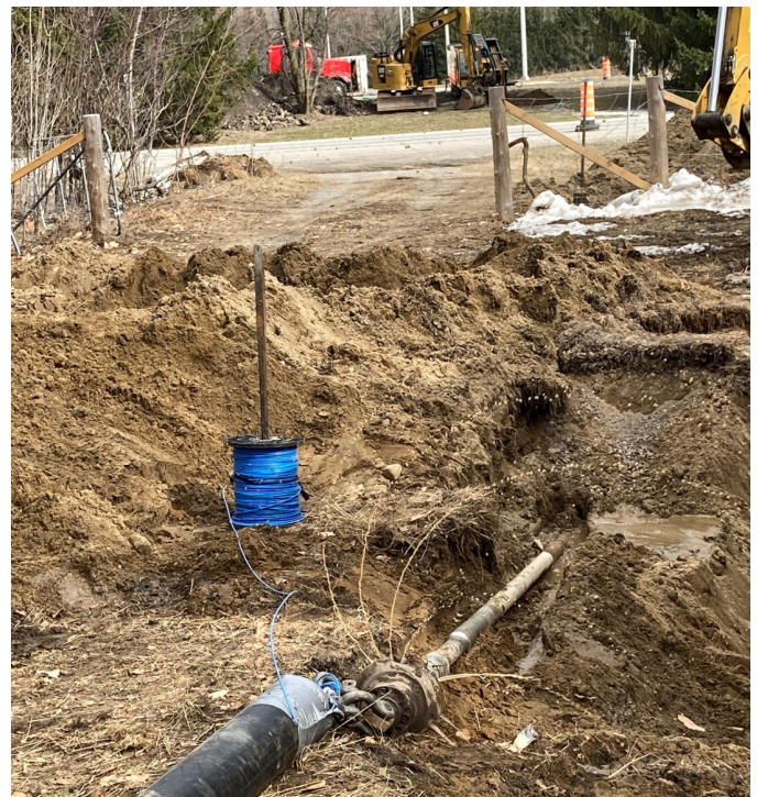
Figure 1 – Installation d'une conduite en forage dirigé (photo 1)
